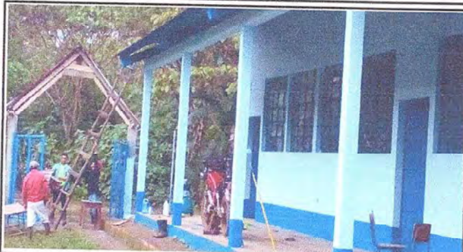
Foto 1: se realizó el cambio de techo de la entrada principal a la escuela.
