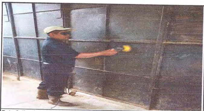
Foto 5: limpiando la pintura anterior de portones de las aulas
