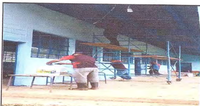
Foto 6: pintando y limpiando vidrios de cada aula
